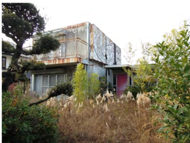
図表－４４ 管理不全の空き家
